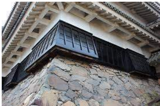
下見板張で造られた松本城の壁
